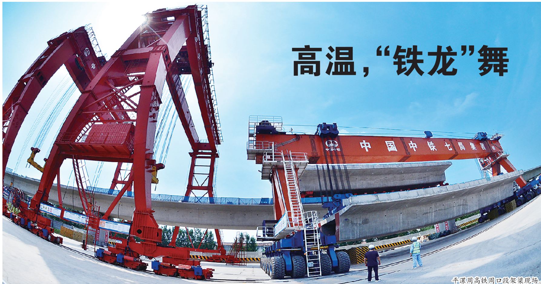
平漯周高铁周口段架梁现场。
